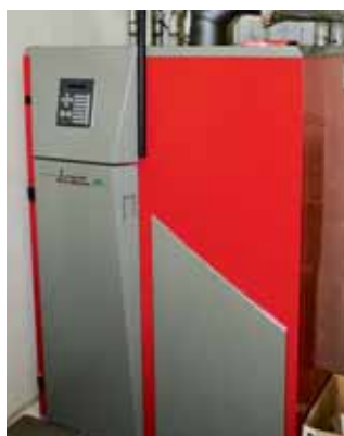
Der Technikraum im Keller beherbergt Steuerung (l.) und An- und Absaugvorrichtungen für die Pelletsheizung
