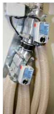
Der Technikraum im Keller beherbergt Steuerung (l.) und An- und Absaugvorrichtungen für die Pelletsheizung
